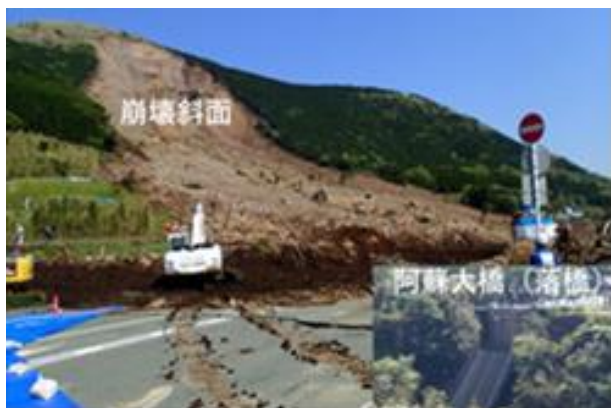
図-1 2016 年熊本地震で発生した阿蘇の斜面崩壊
