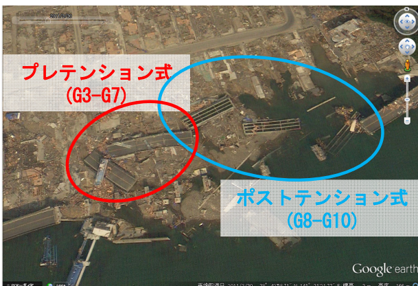
図-13: 歌津大橋の橋梁流失状況
